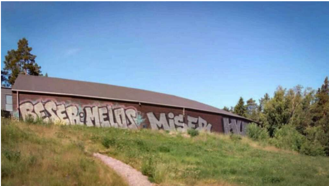
Klottret på carportens baksida vetter ut mot E18, något som vägde tungt i detaljplanen och således i domstolens bedömning.
